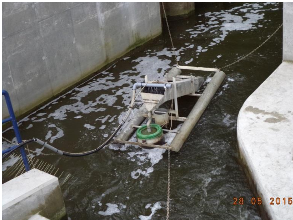
Abbildung 2: Schwimmende Aalrinne am Eingang der Fischaufstiegsanlage Wismar
