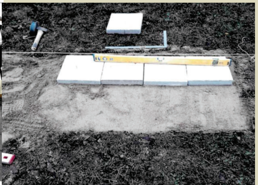
Anfertigung von Gehwegplatten
