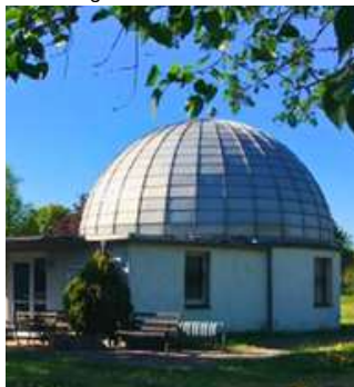
Sanierung Planetarium Lütz
