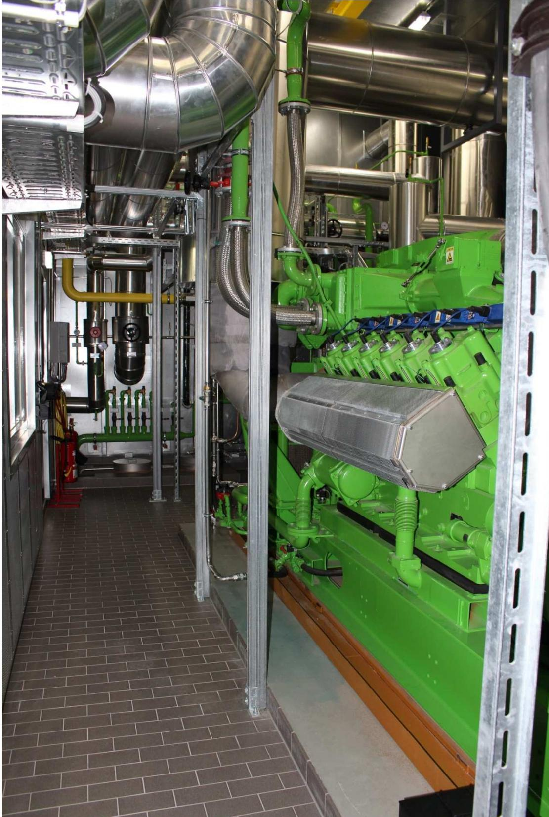
Abb.11 Innenansicht BHKW mit Motor (Westansicht)
