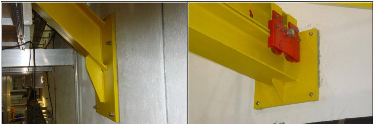
Abb. 4.3 a, b) Halterungen der Traverse (Hilfskonstruktion) an Torushallenwand OST (li./re.)
