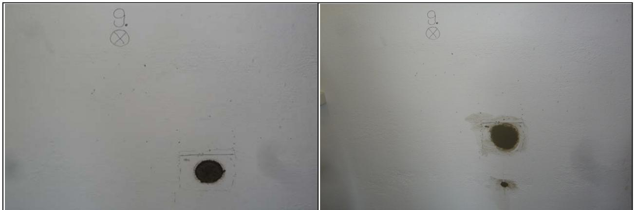
Abb. 3.12 a, b) Bohrloch 9 vor dem Verspachteln (links), Bohrloch 9 nach dem Verspachteln (rechts)
