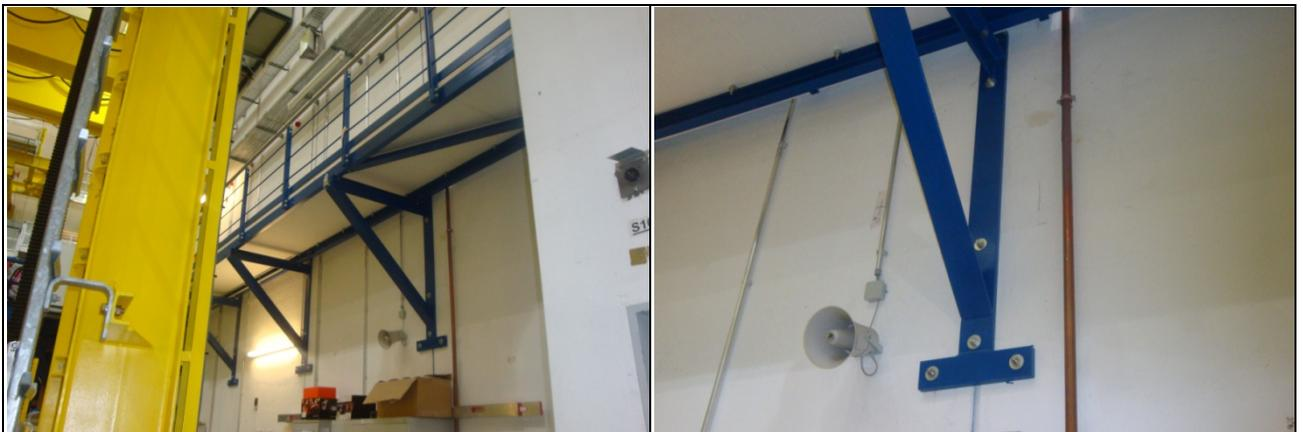
Abb. 4.1 a, b) Laufsteg an Torushallenwand SÜD (li.), Halterung Laufsteg (re.)
