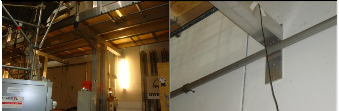
Abb. 4.2 a, b) Rackregal an Torushallenwand OST (li.), Halterung Rackregal (re.)
