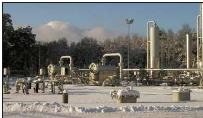
Abb. 8: Gastrocknung mit Vorabscheider/Foto: E.ON Hanse AG
