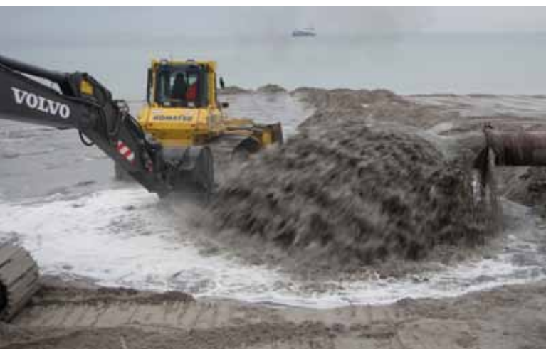
Abb. 3: Verspülung von marin gewonnenem Material für den Küstenschutz / Foto: S. Priewe
