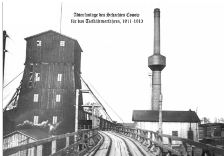
Abb.3: Abteufelanlage Schacht Conow
