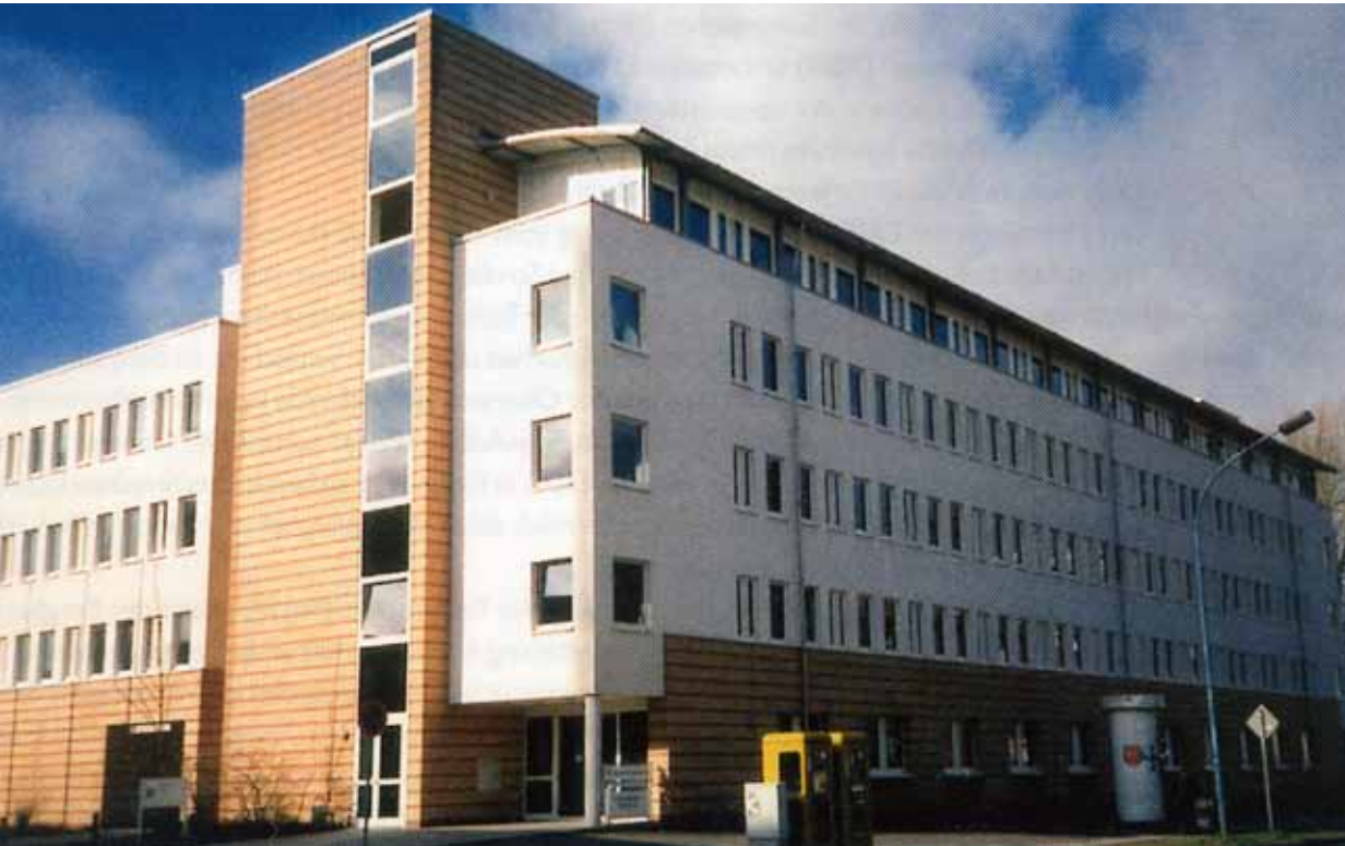
Der heutige Sitz des Bergamtes Stralsund seit 1997 im Gebäudekomplex der Justizbehörden am Frankendamm 17.
