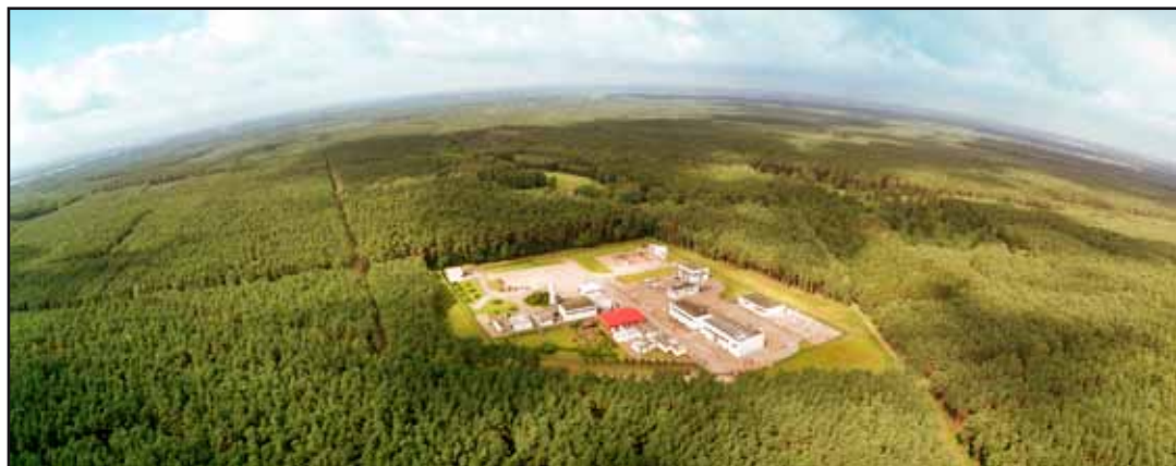
Abb. 2: Betriebsgelände Speicher Kraak Foto: Fechner & Tom GmbH Halle
