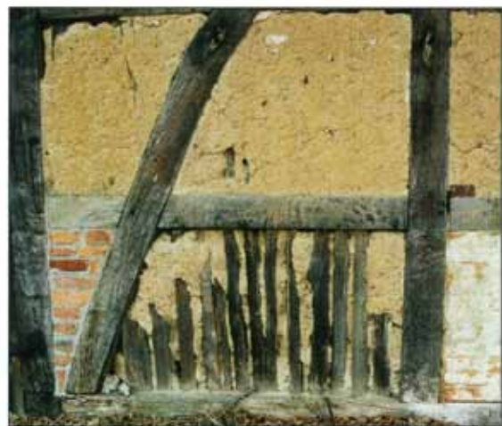
Fachwerkbau in Dreenkrögen südlich von Schwerin: Ausfächerung mit lehmverschmierten Holzstäben, ungebrannten Ziegeln (rechts oben) und gebrannten Ziegeln (rechts unten verputzt).
