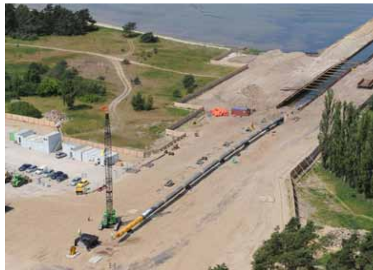
Abb.3: Am 02.07.2010 erfolgte der shore pull für den ersten Leitungsstrang am Anlandepunkt in Lubmin / Foto: Nord Stream AG
