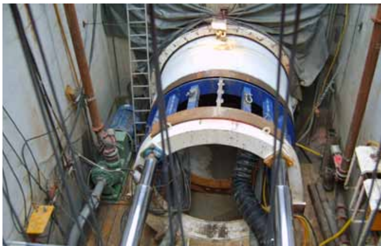
Abb.4: Microtunnel Peenequerung / Foto: Bergamt Stralsund
