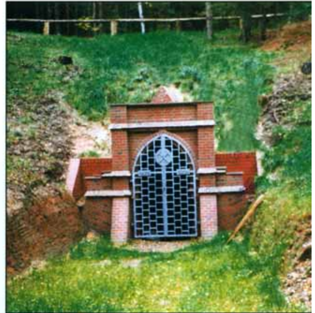
Mundloch des 1873 im Malliöser Unterflöz aufgefahrener Marienstollens vor (1994) und nach der Rekonstruktion (2000)
