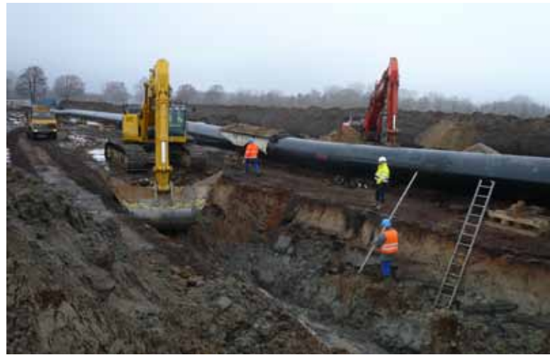
Abb.2: Verlegung der OPAL / Foto: Bergamt Stralsund
