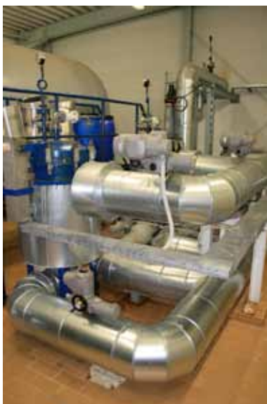
Abb. 7: Übertägige Anlage der GHZ Neustadt-Glewe Foto: K. Obst
