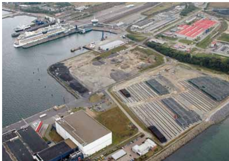
Abb.2: In Mukran wurde ein zentrales Rohrlager und ein Werk für die Betonummantelung der einzelnen Rohre errichtet / Foto: Nord Stream AG
