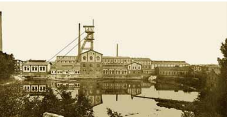
Abb.2: Ansicht Schacht Friedrich Franz Lübtheen
