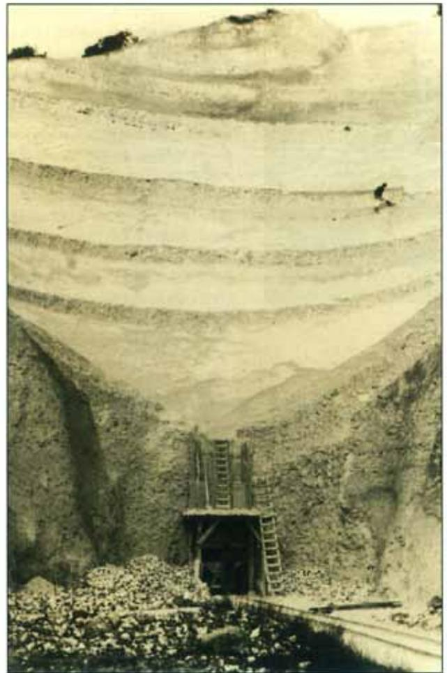
Noch 1954 wurde die Rügener Schreibkreide in Handarbeit in Trichter-Schlitzschuren-Verfahren abgebaut (Werk 2 bei Saßnitz)
