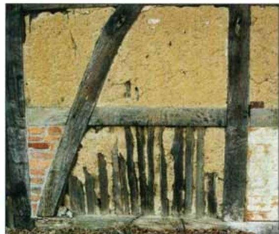
*Fachwerkbau in Dreenkrögen südlich von Schwerin: Ausfächerung mit lehmverschmierten Holzstäben, ungebrannten Ziegeln (rechts oben) und gebrannten Ziegeln (rechts unten verputzt).*
