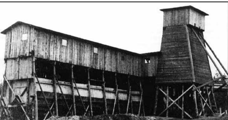
Der Malliß-Schacht mit Kohlebunker zwischen 1948 und 1954. Er förderte Kohle aus 24 m Tiefe.
