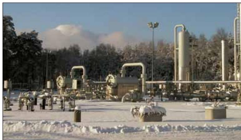
Abb. 8: Gastrocknung mit Vorabscheider/Foto: E.ON Hanse AG
