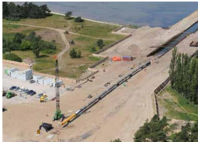
Abb.3: Am 02.07.2010 erfolgte der shore pull für den ersten Leitungsstrang am Anlandepunkt in Lubmin / Foto: Nord Stream AG
