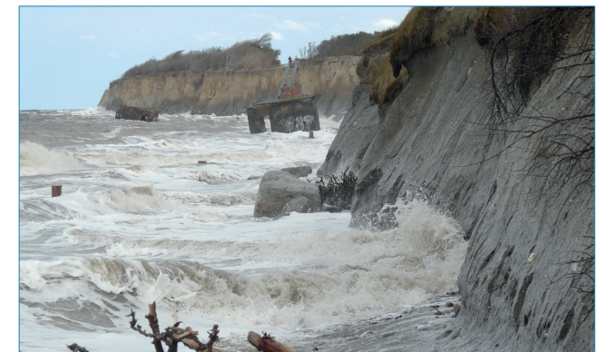
Küstenerosion während einer Sturmflut.
