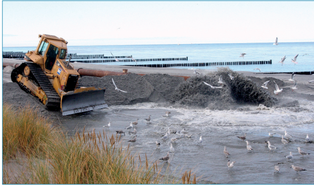
Aufspülungen mit Sand sind die tragende Säule des Küstenschutzes in M-V.
