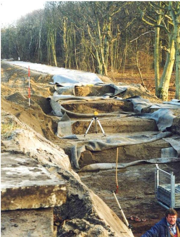
3.1.1.2 Bau des Geotextilwalles Graal-Müritz in Lamellen Bauweise im Jahr 2000 (GÖRICKE).
