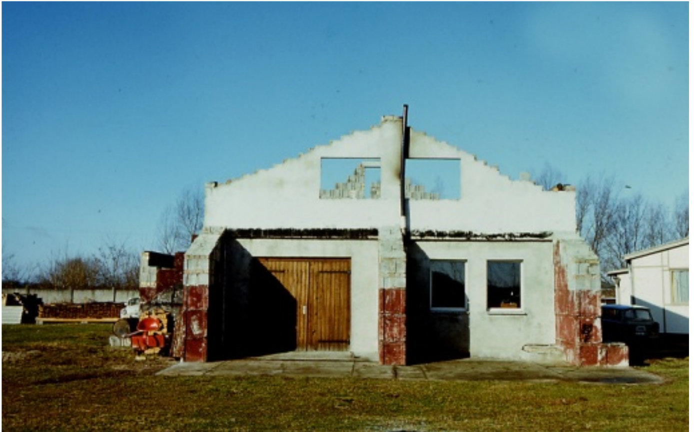
Nach der Übernahme des Konsultationsstützpunktes Georgenthal durch die Staatsjagd wurde der Bunker der Radarstation in Heinrichswalde ausgebaut - danach wurde der Abriss verfügt (Foto: E.Hoyer).
