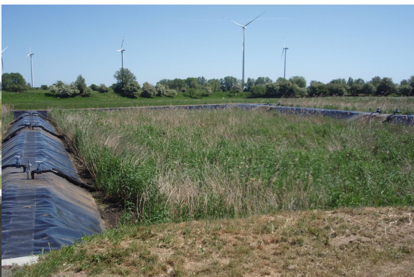
Bild 5.10: Klärschlammvererdungsanlage Kläranlage Strasburg
