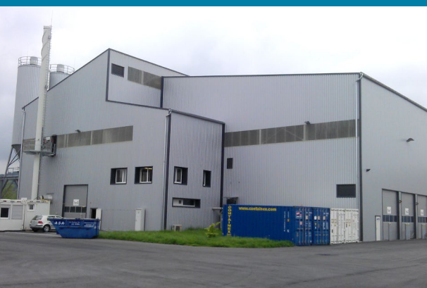
Monoklärschlammverbrennung Großwilfersdorf (Österreich)
