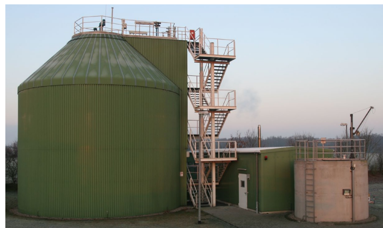
Bild 5.3: Faulbehälter Kläranlage Zarrentin mit 700 m 3 Nutzvolumen
