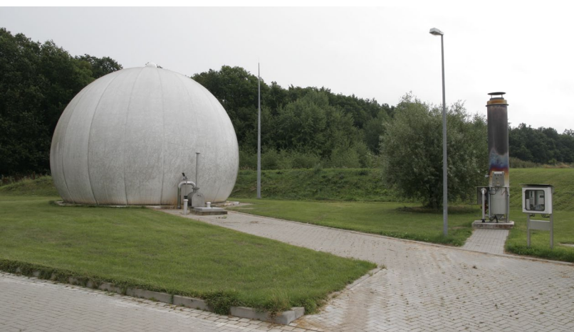
Bild 5.4: Gasspeicher Kläranlage Bad Doberan
